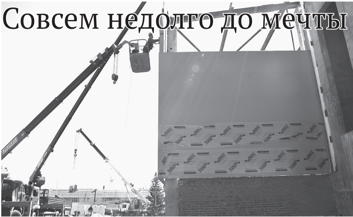
Спорткомплекс. На обшивке стен.
